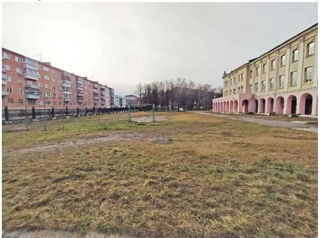
Отсутствует покрытие футбольного поля;
