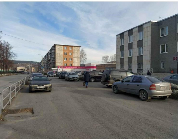
Перед зданием Администрации отсутствует разделения автомобильного и пешеходного движения.
