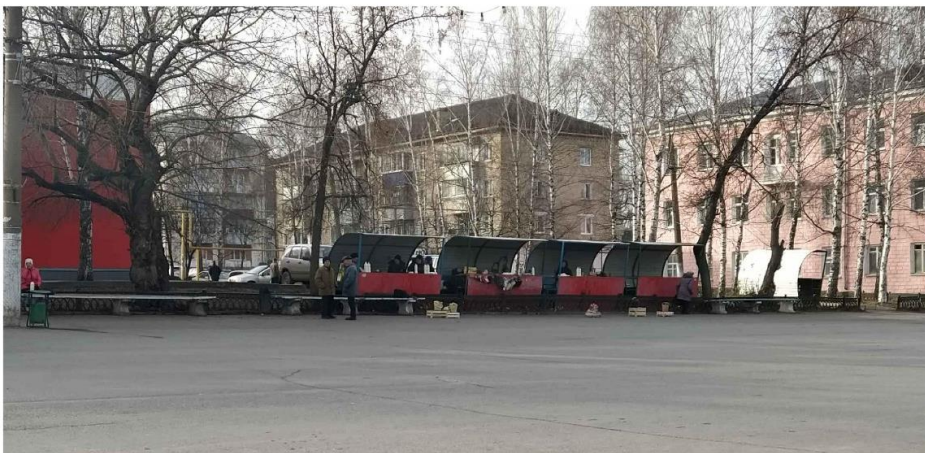
Торговых павильонов, расположенных на Центральной площади по ул. Ленина, не имеют общего стилового решения с другими объектами, расположенными на территории площади.
